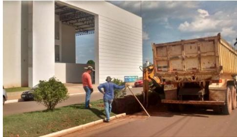
Abertura de Bueiros para confecção de caixa de captação de água pluvial – Av. Belo Horizonte.
