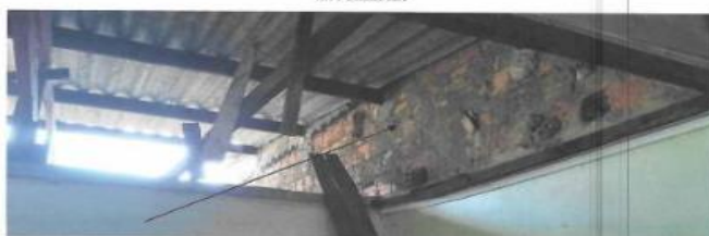
FOTO 15. Estrutura apoiada na alvenaria.
