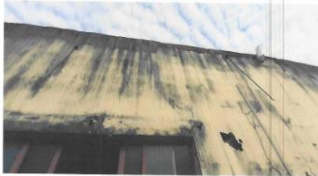
FOTO 08. Estrutura – Ausência de cinta de amarração.
