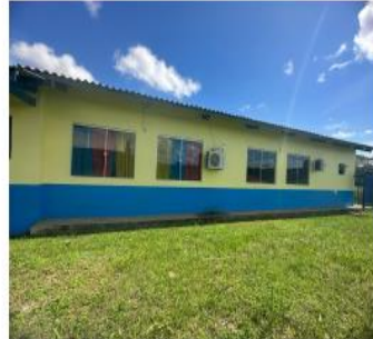
Imagem 2 - Fachada lateral das salas construídas
