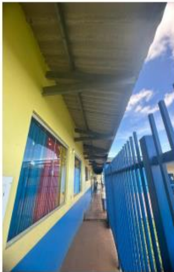
Imagem 3 - Acesso as salas de aulas construídas
