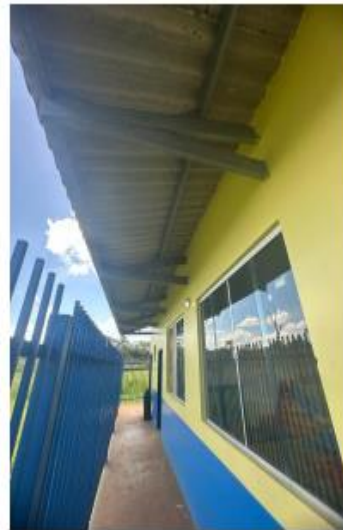
Imagem 4 - Acesso as salas de aulas construídas
